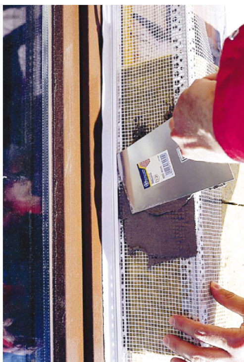
Рис. 2.24. Усиление внешних углов
