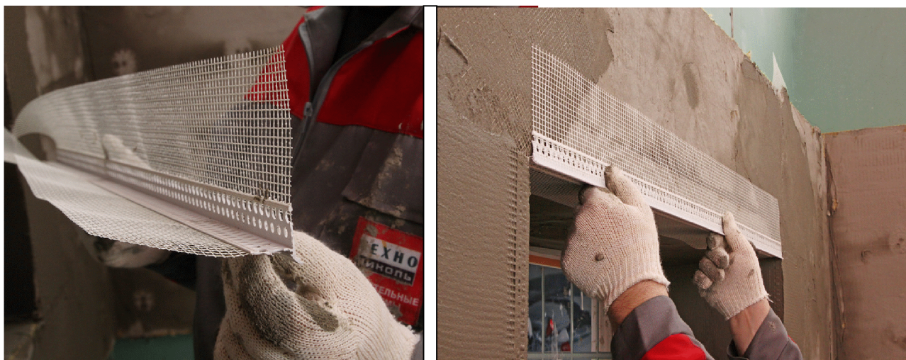
Рис. 2.27 Армирование горизонтальных углов
