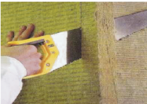
Рис. 2.12. Обрезка теплоизоляционного материала
