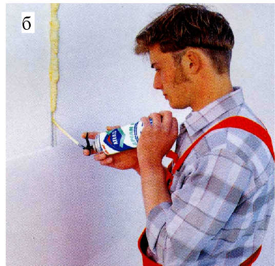
Рис. 2.13. Заполнение технологического зазора а - заполнение щелей утеплителем, б - заполнение тонких швов полиуретановой пеной
