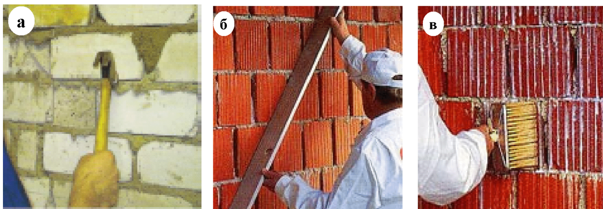
Рис. 2.4. Подготовка строительного основания
