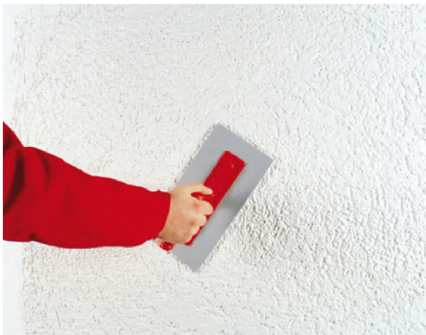
Рис. 2.32. Нанесение защитного слоя
