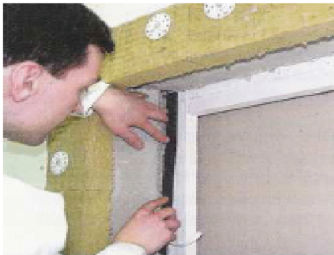
Рис. 2.18. Наклейка уплотнительной ленты с напуском на коробку
