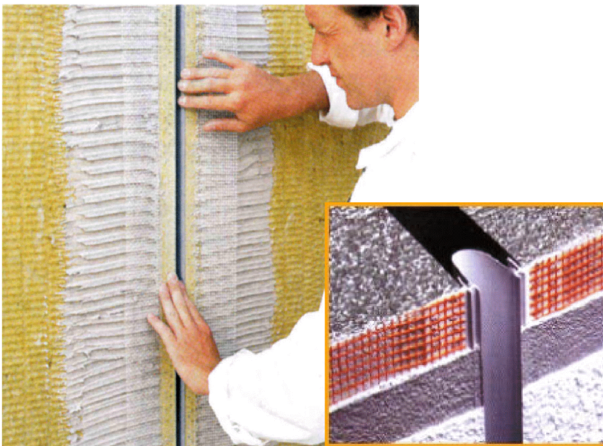
Рис. 2.26 Установка компенсационного элемента
