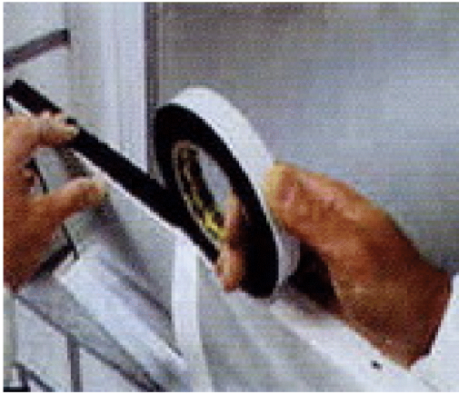
Рис. 2.15. Наклейка противошумной ленты
