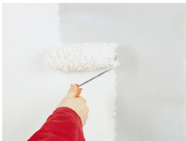
Рис. 2.31. Нанесение грунтовки
