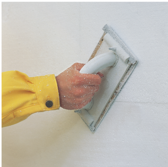
Рис. 2.14. Шлифование утеплителя
