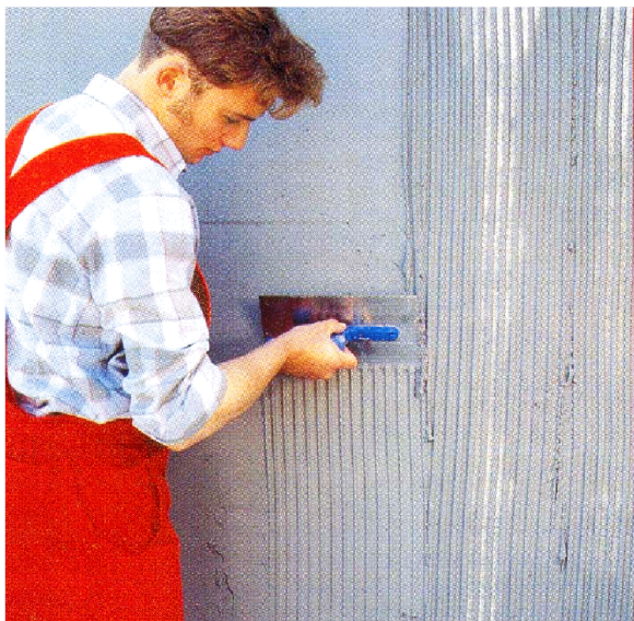
Рис. 2.29. Армирование щелочестойкой армирующей сеткой
