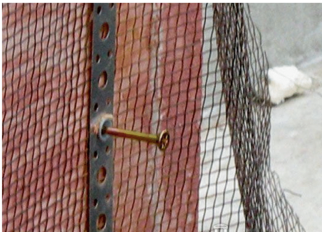
Рис. 2.37. Крепление стальной сетки к плитам утеплителя
