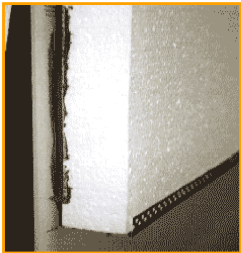
Рис.2.10. Установка первого ряда теплоизоляционных плит на цокольный профиль
