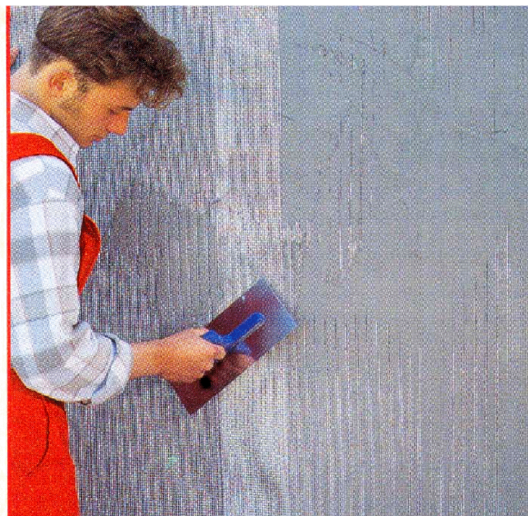
Рис. 2.30. Затирка армирующей сетки
