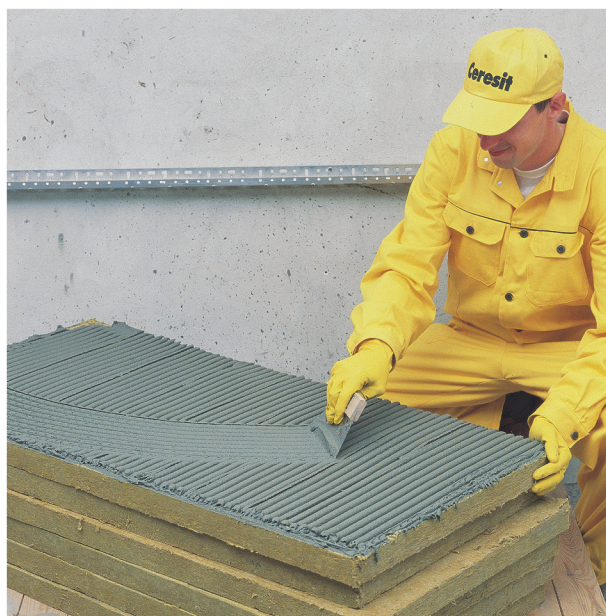
Рис. 2.9. Нанесение клеевого состава сплошным способом
