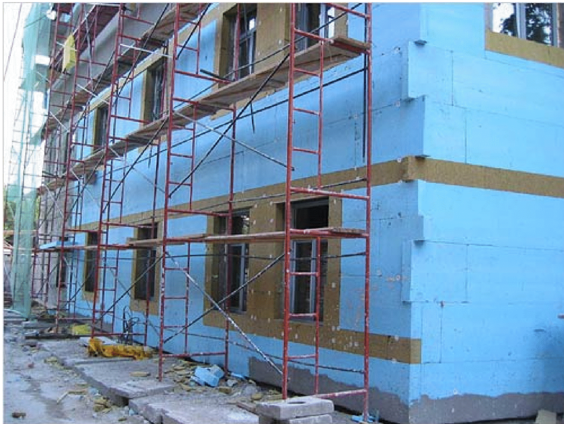
Рис. 2.11. Формирование угла утеплителем
