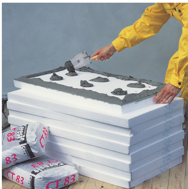
Рис. 2.8. Нанесение клеевого состава маячковым способом
