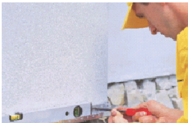
Рис. 2.5. Установка цокольного профиля
